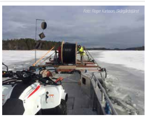
Kabeldragning till Hasselö/Sladö
