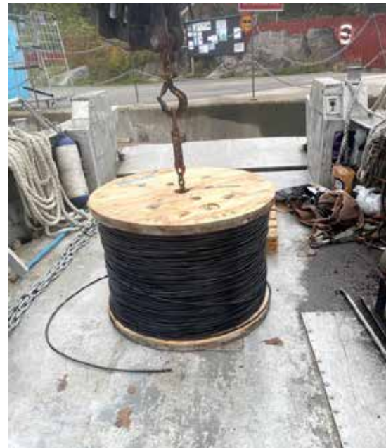
2000 m sjökabel klar för utläggning. Foto: Sune Fogelström
